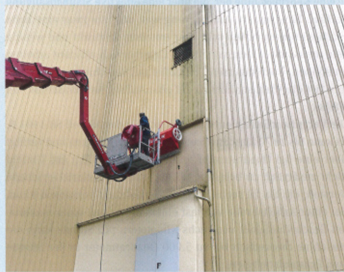
Gereinigt wird in 1,60 Meter breiten Bahnen von oben nach unten, damit kein Schmutzwasser auf die bereits gereinigten Flächen läuft.
